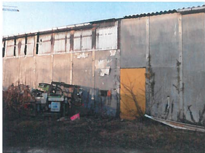
MOY 1 : Cuve enterrée de gazole dans l'usine
