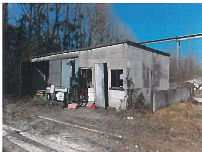
MOY 3 : 2 ex cuves aériennes de fioul domestique et de gazole
