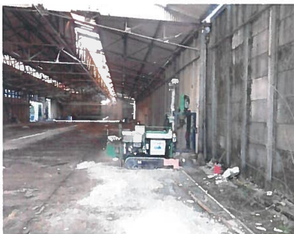
MOY 5 : Emplacement supposé d'une ancienne chaudière de fioul lourd avec cuve
